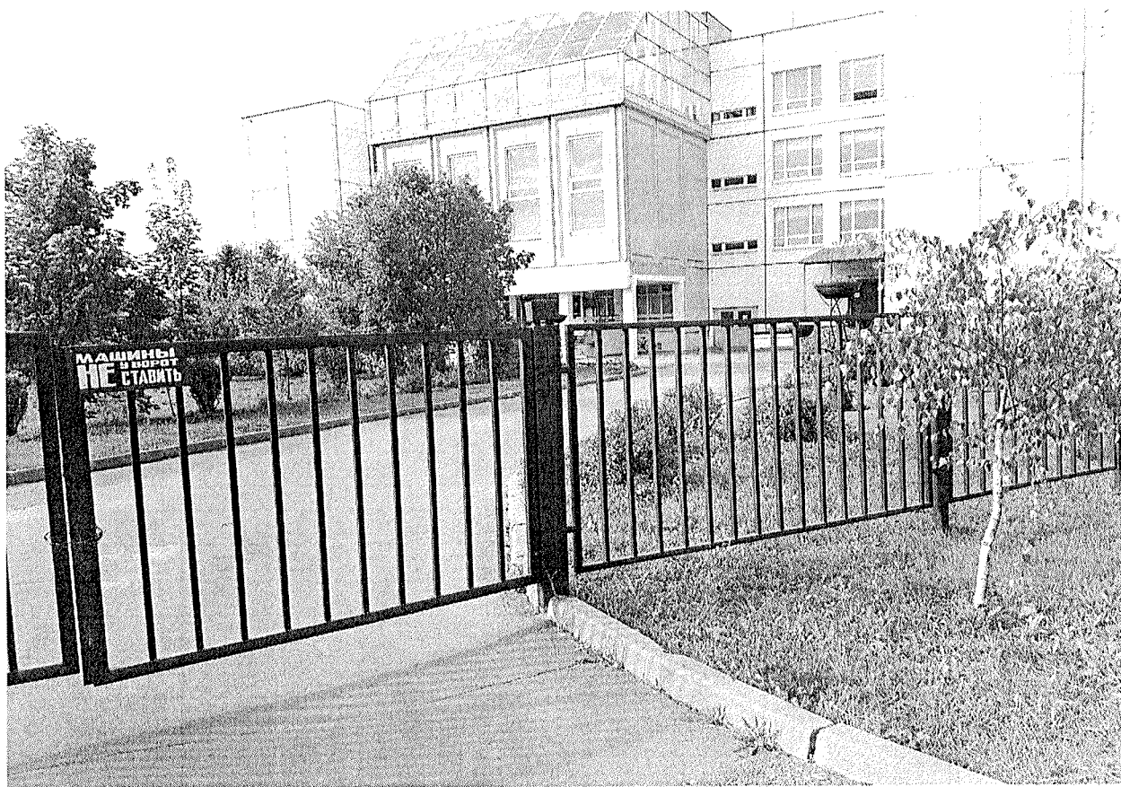
Рис 1. Территория, прилегающая к зданию
